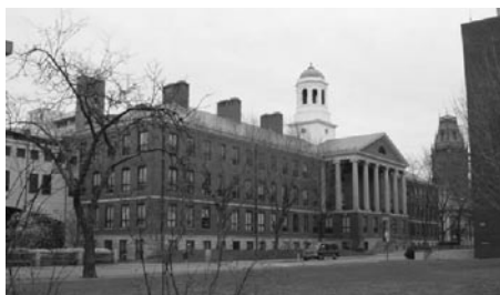
Mallinckrodt Building. 岸研は遠方の右翼3階にあった。
